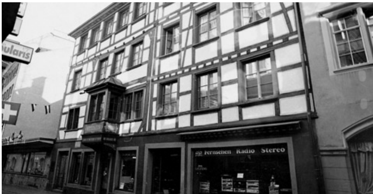
Erstes AZ-Gebäude St.Gallen (4 Winden), (Foto Stadtarchiv, St.Gallen)
